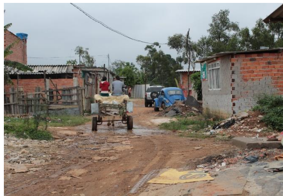
Foto 02: Rua com solo exposto
