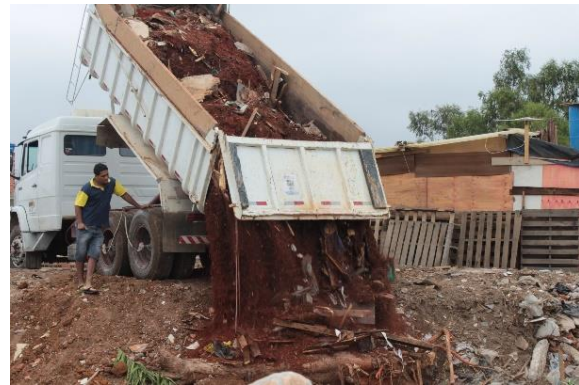
Foto 06: Despejo ilegal de entulho
