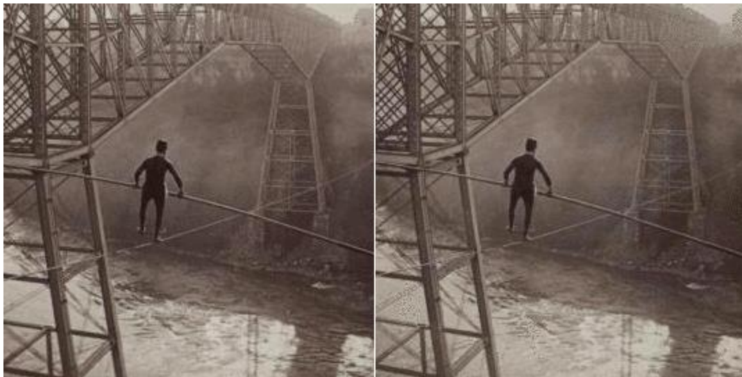
Figura 3 – “ Dixon crossing Niagara below the Great Cantilever Bridge, U.S.A. 1895-1903 ” (par estereoscópico de autor desconhecido) – Fonte: https://stereo.nypl.org/view/210
